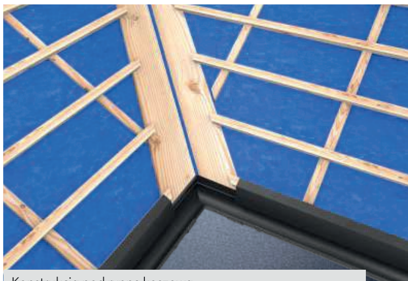
Konstrukcja pod rynnę koszową
