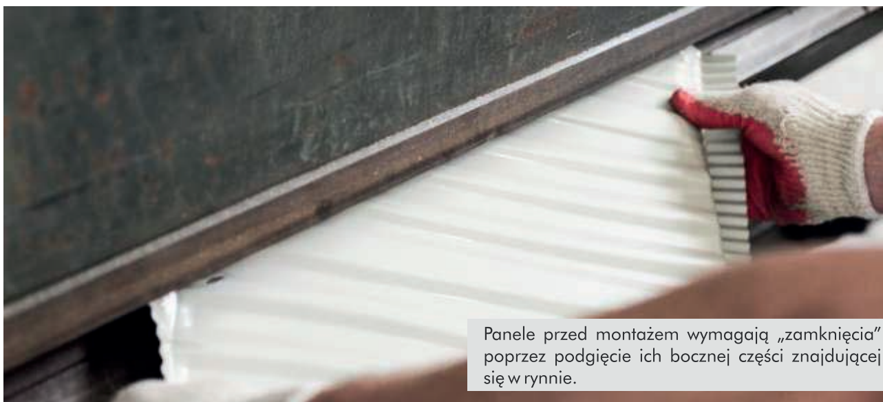
W odróżnieniu od paneli z posypką, panele regle można ciąć niblerem, bez ryzyka jego uszkodzenia
