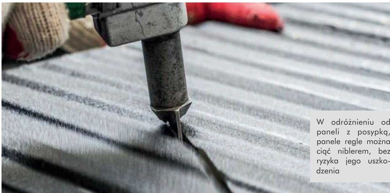
Odcinanie niepotrzebnej części panela
